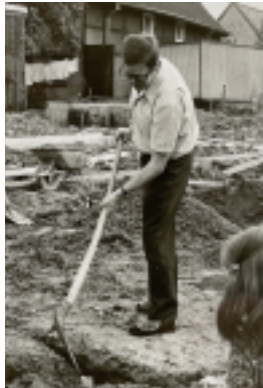
Pastor Manfred Thies bereitete auch mit der Schaufel ein gutes Fundament für das ev. Gemeindehaus.
