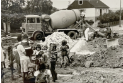
Die Streifenfundamente werden gegossen.
