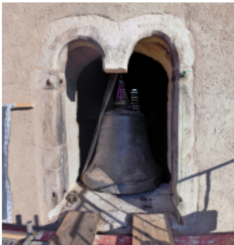
Durch das erweiterte Schallfenster werden die Glocken aus dem Turm geholt. Foto: Gerken
